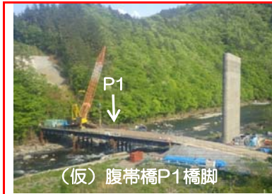
⑩施工：大豊建設
