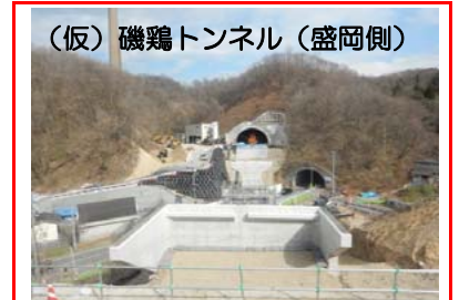
②施工：飛鳥建設
