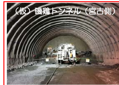
①施工：大成建設
