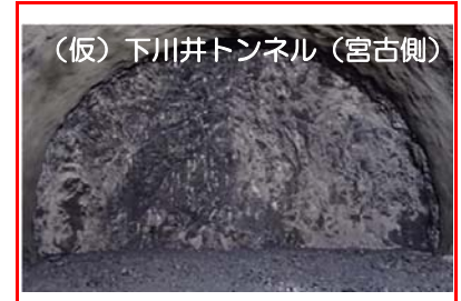
⑪施工：大成建設
