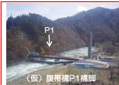
⑩施工：大豊建設
