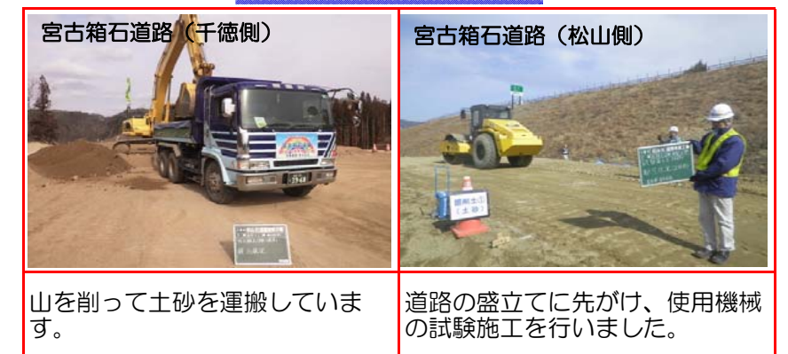
②施工：松尾建設
