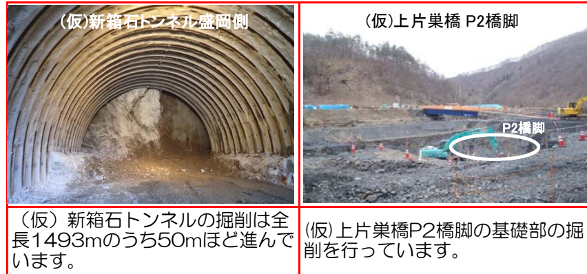
⑥施工：安藤・間
