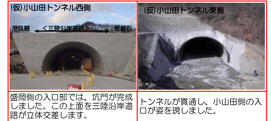
①施工：前田建設工業
