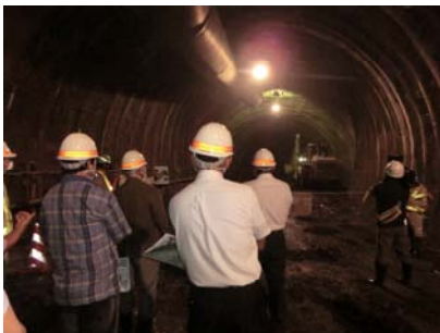
腹帯第1トンネル掘削現場
