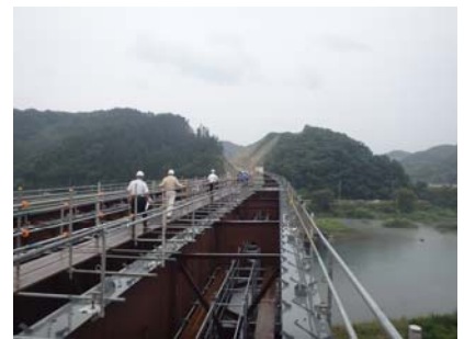
関伊川橋上部工の施工現場
