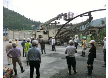
間近で見る迫力に圧倒されます
