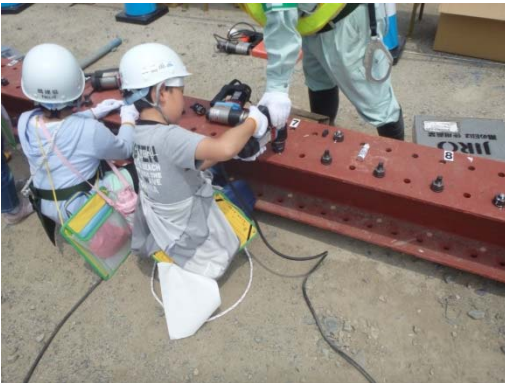
▲高圧ボルト締め付け中
