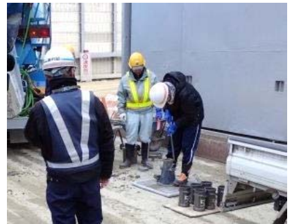
コンクリート試験実体験の様子
