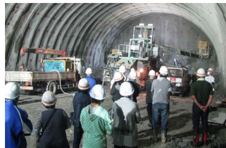
岩盤に火薬を装填する様子を見学 久慈
