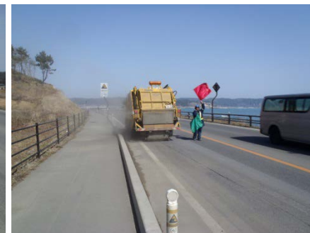
▲路面清掃車による清掃
