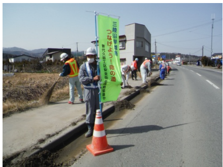
▲人力による路肩・歩道清掃
