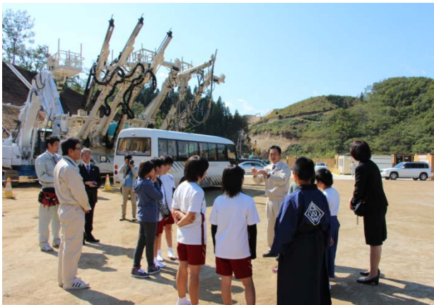
▲花輪小学校の児童の皆さんに 工事で活躍する建設機械を紹介
