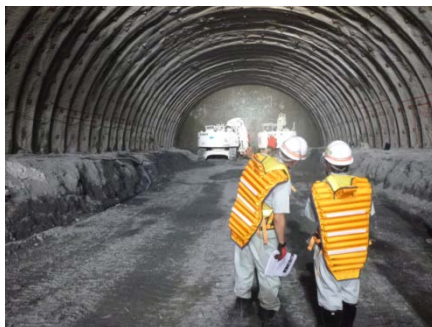
▲小本トンネルの掘削現場で掘削作業について学習
