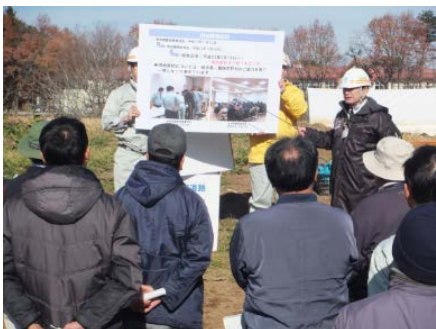
▲三陸国道事務所戸嶋副所長が三陸沿岸道路の工事概要を説明
