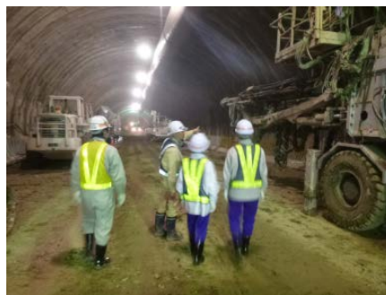
▲トンネル工事現場を見学 大きな機械にビックリ!
