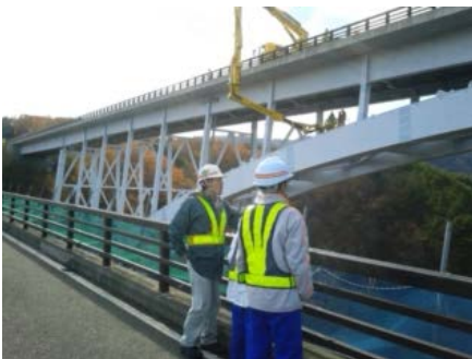
▲橋梁点検現場を見学 安全を守る大事な仕事です
