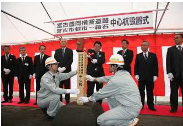
中心杭を打ち込む宮古市山本市長
