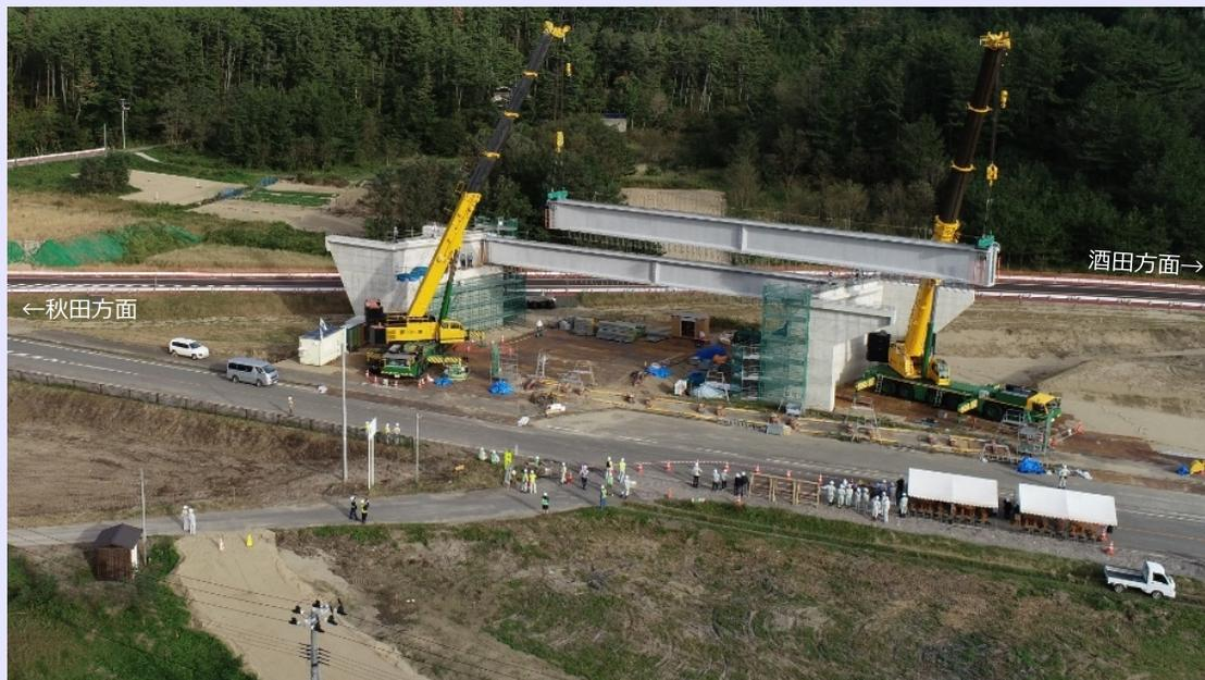
クレーン2台で橋桁を架けています
