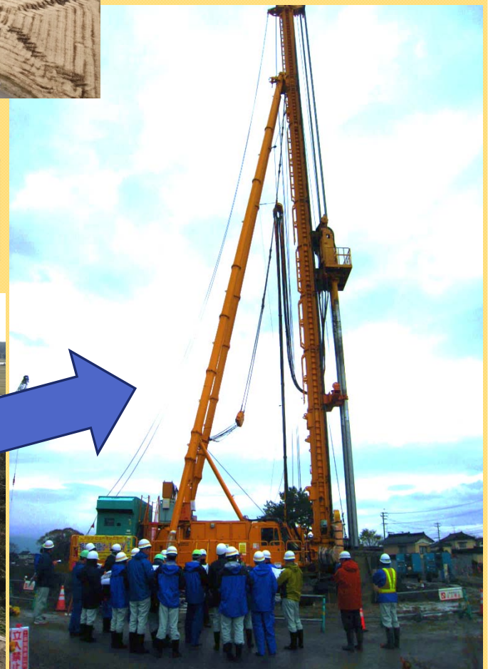
★地盤改良機を間近で見ました。
