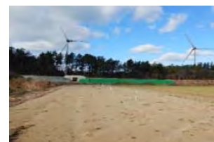
(9) 藤崎地区 No.324(並走区間)
