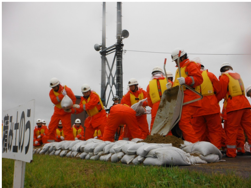
▲積み土のう工法
