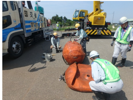
▲浮きの組み立て状況
