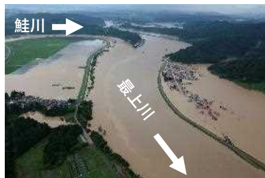
【国】最上川44.3k付近(出水の状況)
