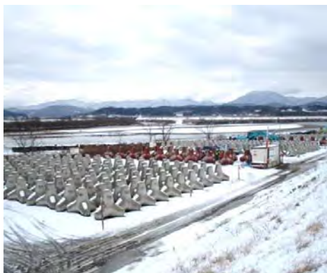
▲少々、雪で見づらいますが・・・740個のブロック製作が完了しました。
