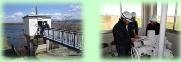
▲最上川 新堀樋門
