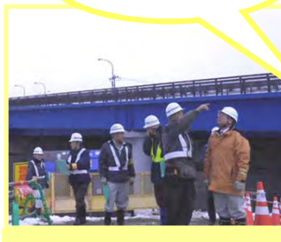
橋梁補修工事現場点検の様子
