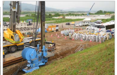
▲ 矢板打設状況を見学している様子
