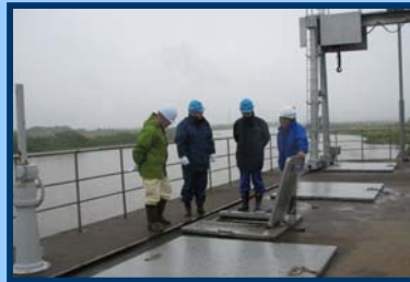
酒田上水道取水口
