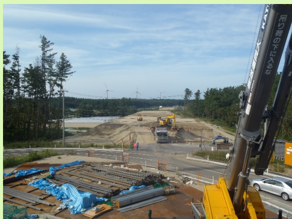
★遊佐町藤崎地内のICT土工
