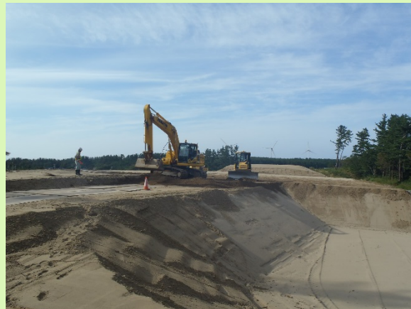
★遊佐町藤崎地内のICT土工
