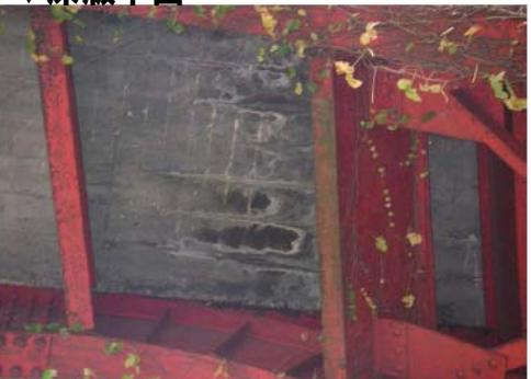
●桁間に漏水を伴う遊離石灰がみられる。
