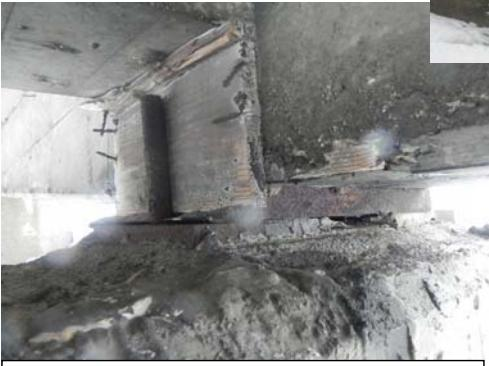
●支承部の桁内側に型枠の残材のような木片がある。●沓座モルタルの一部にひびわれが発生し欠損している。
