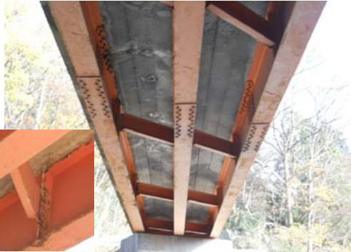
●床版に漏水・遊離石灰がみられる。また、一部に桁腐食がみられる。
