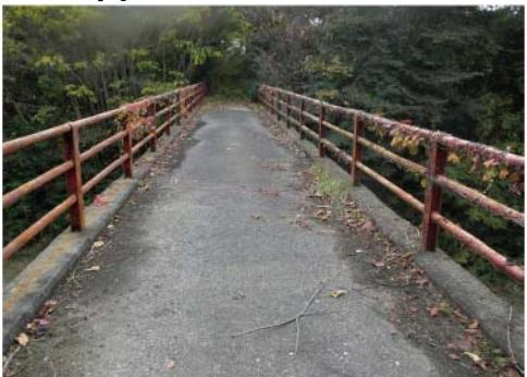
●高覧に腐食がみられる。腐食進行による、地覆コンクリートの剥落注意
