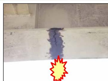
←衝突による桁に亀裂が発生した事例
