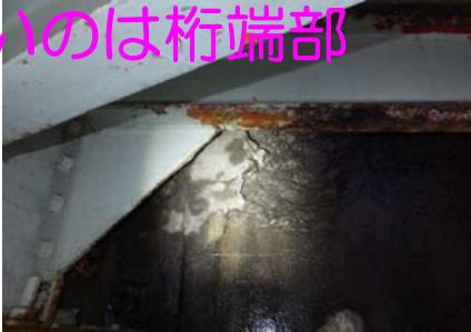
胸壁が剥落し壁厚が減少。背面の陥没の危険性があり。
