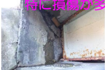
胸壁にひび割れあり、背面の陥没の危険性があり。
