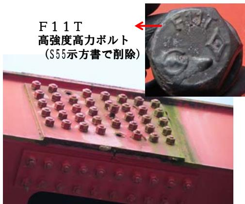
高力ボルトの破断脱落
