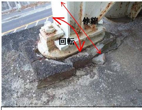
●沓座モルタルがひび割れ、剥離が生じている。
