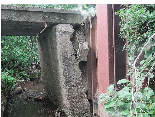
写真 4-23 【損傷】橋台の傾斜
