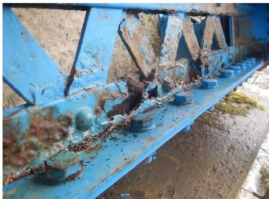
写真 4-20 【損傷】鋼材の腐食
