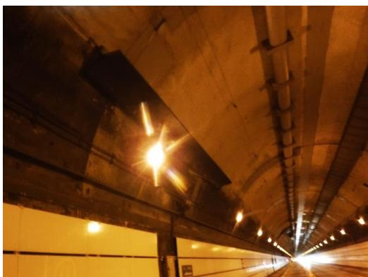
写真4－29 【損傷】漏水防止版の腐食
