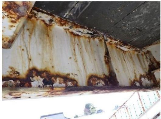
写真4-38 【損傷】腐食
