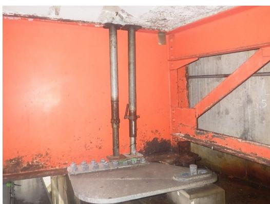
写真4-11 【損傷】主桁腐食
