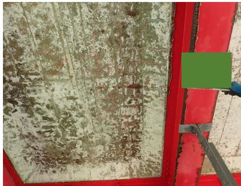
写真 4－4 6 RC 床版のひびわれ
