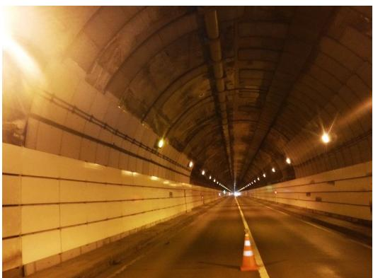
写真4－30 【対策】漏水防止版交換
