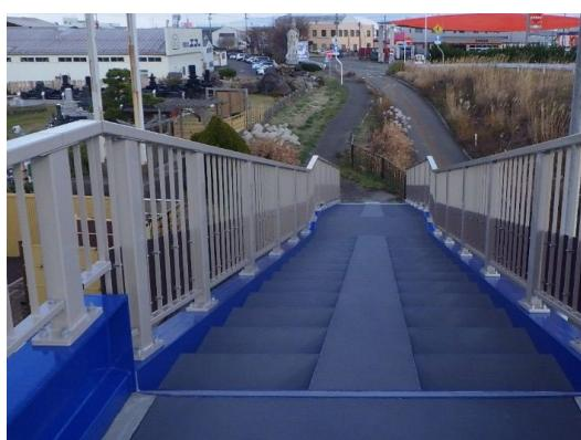
写真4-36 【対策】上部工架替え
