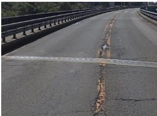
写真4-2 【損傷】伸縮装置の漏水
