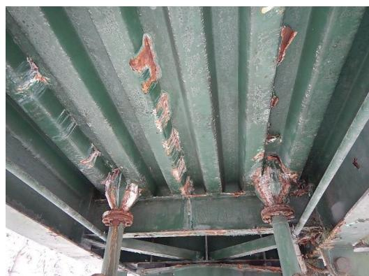
写真4-41 【損傷】腐食・防食機能の劣化
