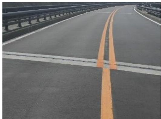
写真4-3 【損傷】伸縮装取替
