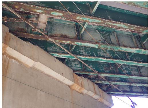
写真 4－4 7 主桁の全般的な腐食
