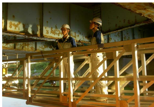
▲橋梁点検車による床版ひび割れ状況確認
