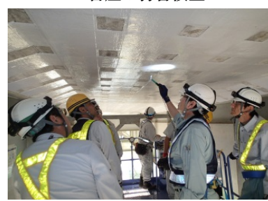
▲床版の打音検査
