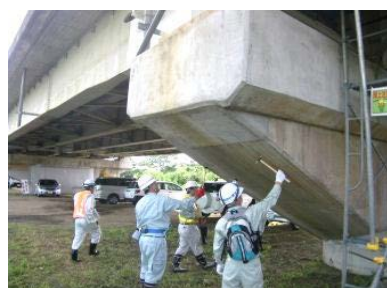
▲橋脚張出し部の打音検査
