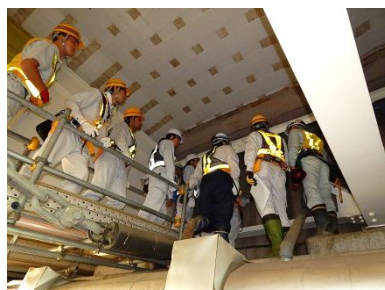
▲桁端部の状況確認
