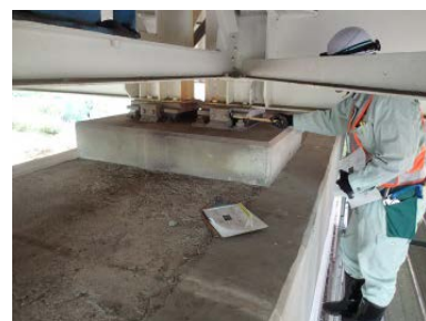
▲沓座の打音検査
