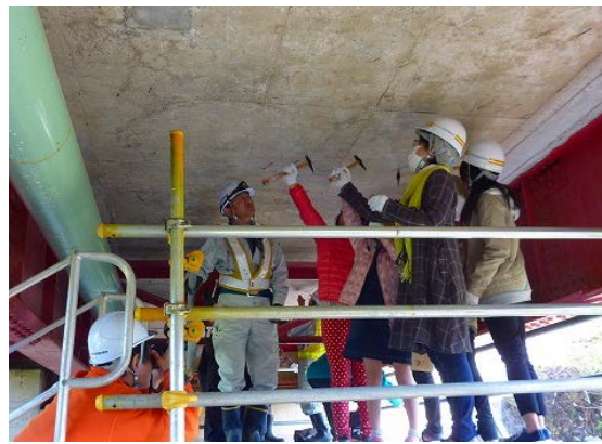
みんなで足場にあがり、コンクリート床版を叩きました。
