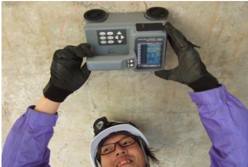
コンクリートを壊さないで鉄筋の位置を調べました
