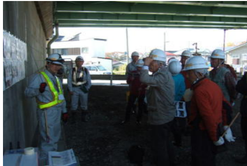
北山こ線橋で補修内容を聞きました
