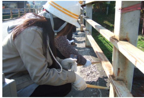
地覆コンクリートを叩いてもろくなった部分を確認しました
