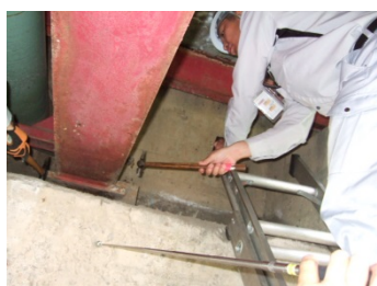
▲桁端・杓廻りの損傷状況確認
