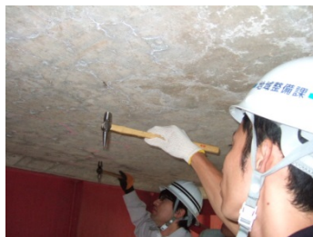
▲床版の打音による点検状況
