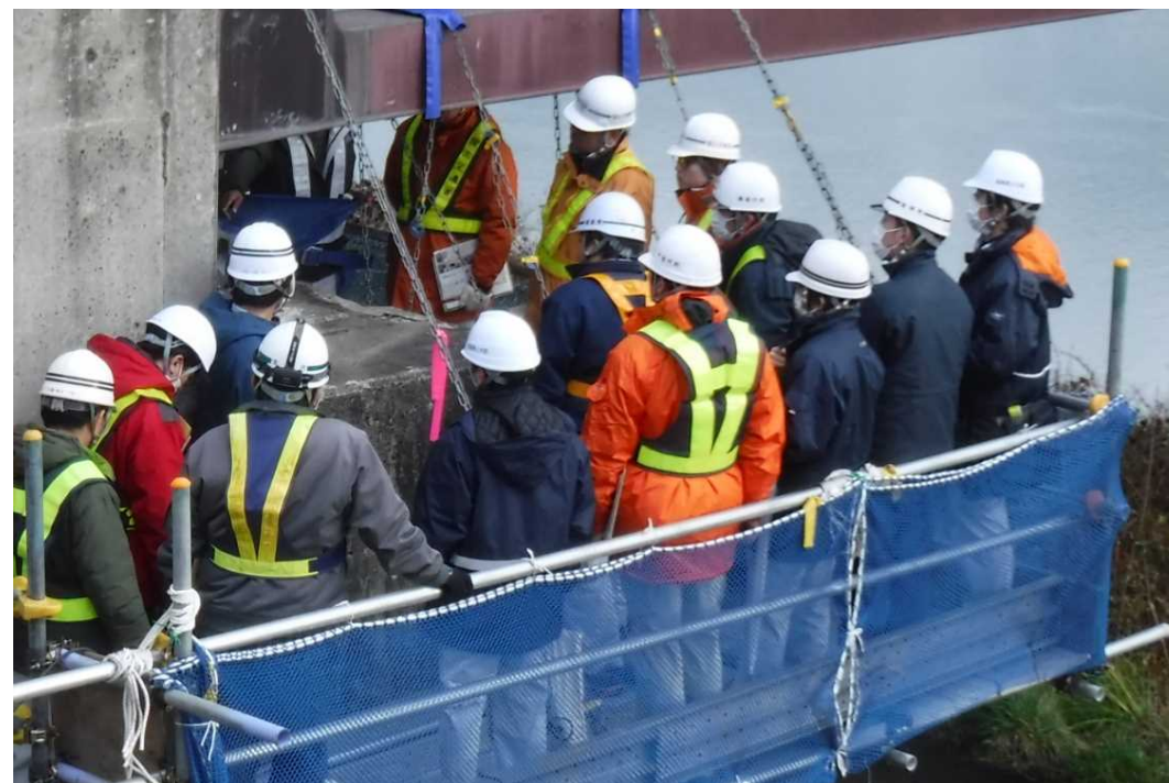
講習状況(昭和大橋)
