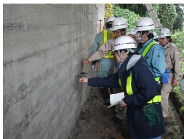
▲橋台の打音検査
