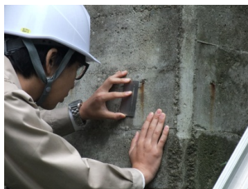
▲クラックスケールによるひび割れ状況の確認
