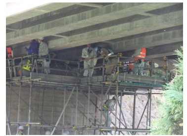
▲主桁の打音検査
