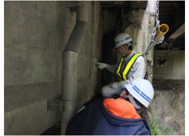
▲桁端・沓廻りの損傷状況確認
