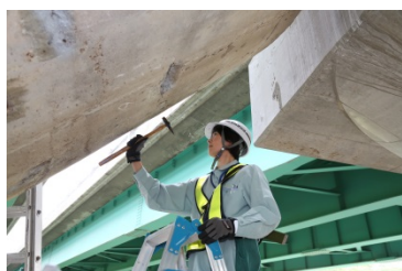
▲橋脚の打音検査
