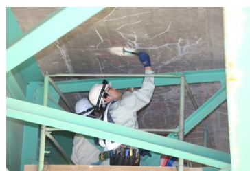
▲床版の打音検査
