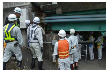
▲桁端・杓廻りの損傷状況確認
