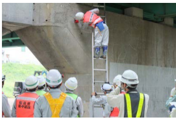
▲クラックスケールによるひび割れ状況の確認
