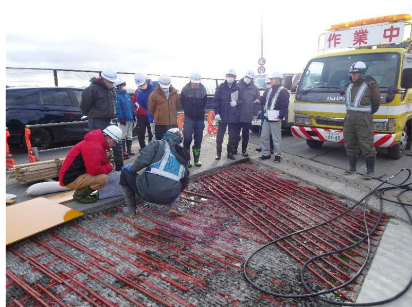
▲現地研修(八甲田大橋)
