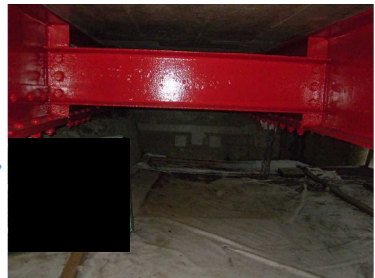
写真4-15 【対策】主桁の補修・塗替え
