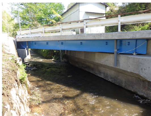
写真4-10 【全景】葛子平橋
