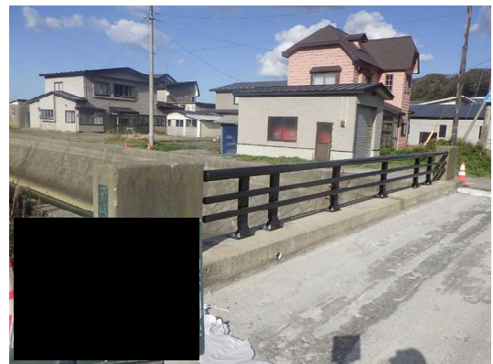
写真4-6 【対策】防護柵取替え
