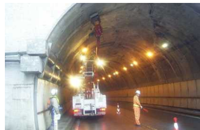
写真2-2 トンネル点検状況
