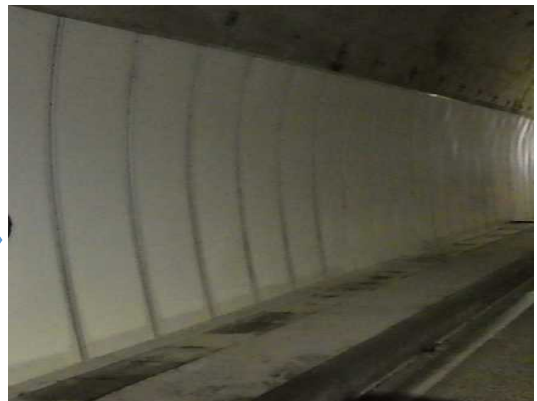
写真4-18 【対策】面導水施工
