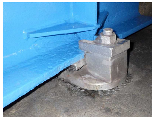
写真4-12 【対策】支承防錆（金属溶射）
