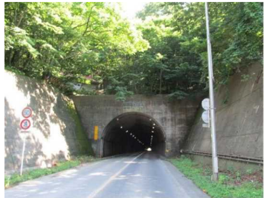
写真4-16 【全景】大間越トンネル
