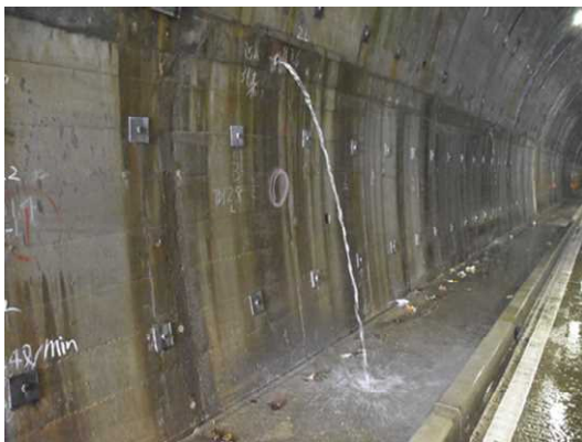
写真4-17 【損傷】漏水
