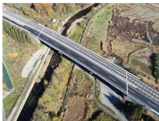
写真4-9 【対策】床版取替
