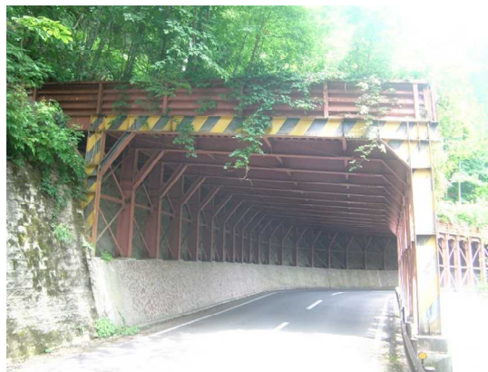
写真 4-19 【全景】宇樽部スノーシェッド
