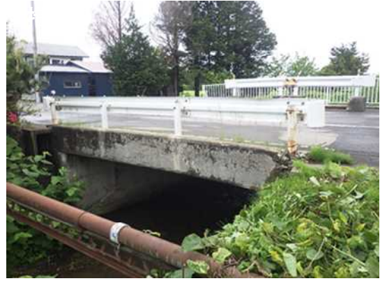
写真4-1 【全景】松野木橋
