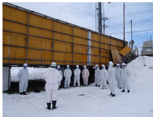
写真5-2 橋梁補修工事の施工管理研修
