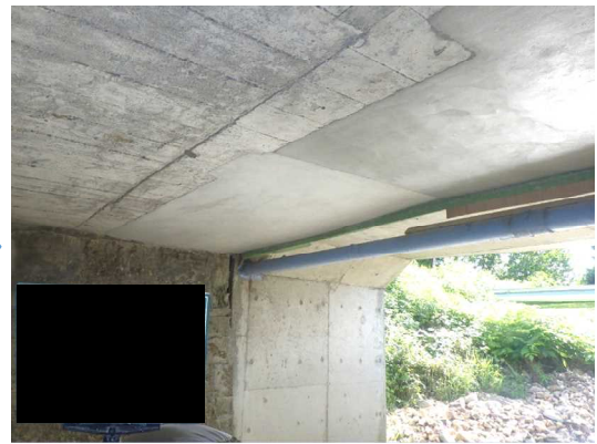
写真4-3 【対策】断面修復
