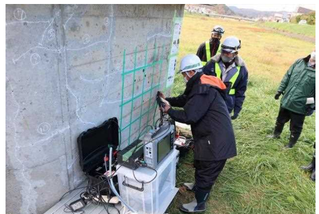
▲非破壊によるコンクリート中の鉄筋腐食評価
