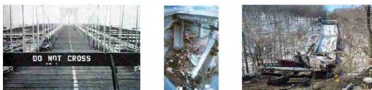
ケーブル切断事故後、通行止めになったブルックリン橋の歩道 (「高速道路と自動車」1981年11月から引用)
