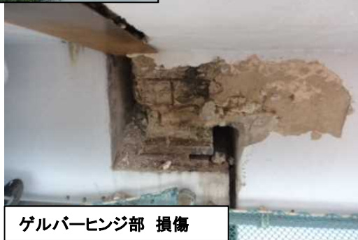
橋脚 断面欠損と鉄筋露出
