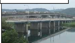
全景(手前側橋梁)
