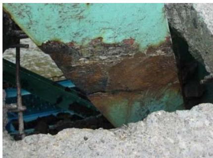
コンクリート埋込み部の破断
