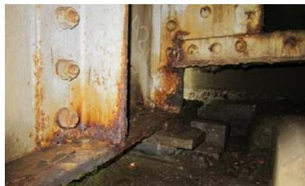
桁端部の腐食
