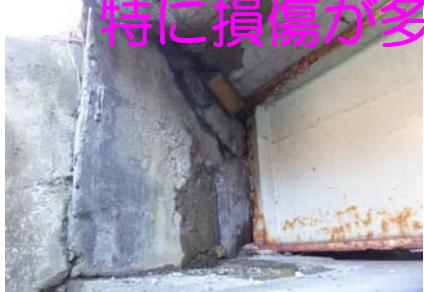
胸壁にひび割れあり、背面の陥没の危険性があり。
