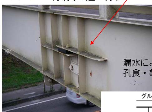
漏水による腐食・孔食・亀裂に注意
