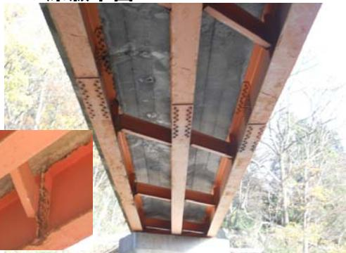
●床版に漏水・遊離石灰がみられる。また、一部に桁腐食がみられる。
