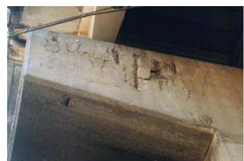
剥離鉄筋露出
