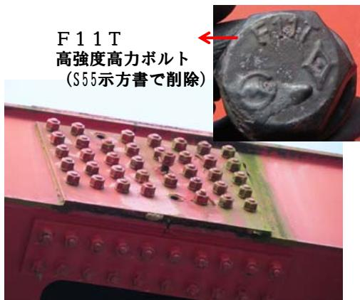
高力ボルトの破断脱落
