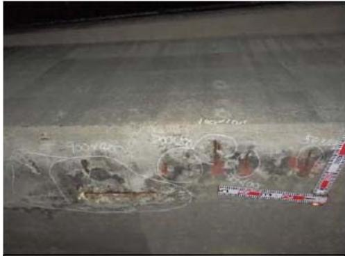
●主桁下面隅角部に剥離・鉄筋露出が
