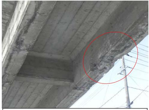
●車両接触に起因する欠損箇所があり、鉄筋の露出もみられる。
