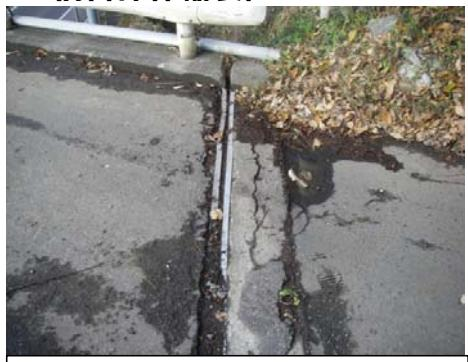
●伸縮装置の橋台側表面にひび割れがみられる。
