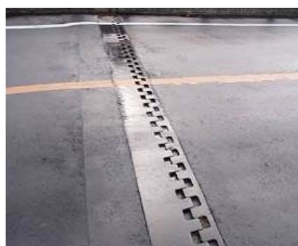
鋼製ジョイントの例(荷重支持型)
