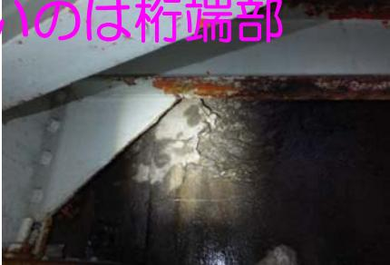
胸壁が剥落し壁厚が減少。背面の陥没の危険性があり。
