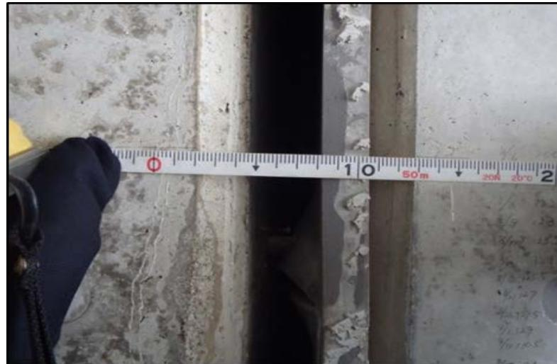
損傷状況(不等沈下による目地の開き)
