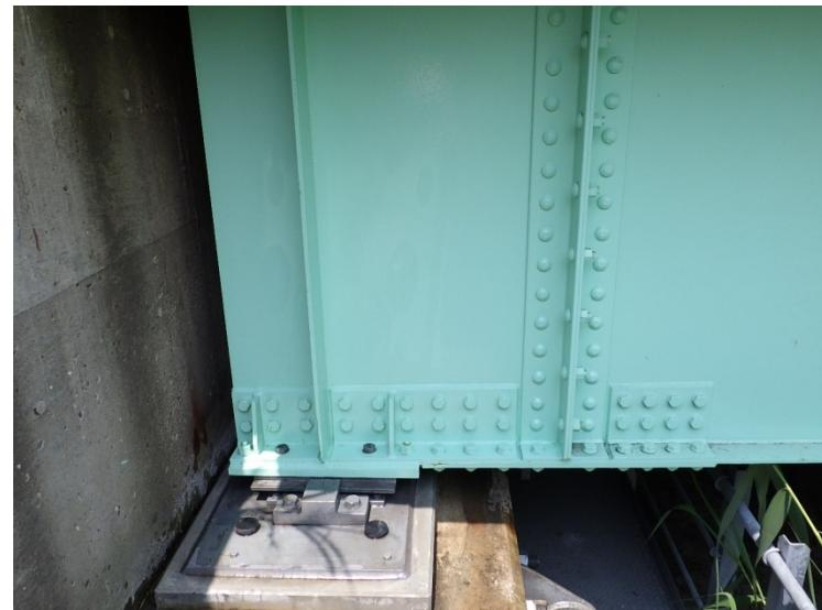
補修完了(当て板補修)
