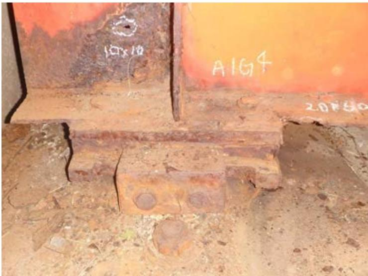
損傷状況(主桁の腐食・変形・欠損)
