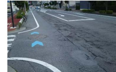
占用工事が起因する路面損傷
