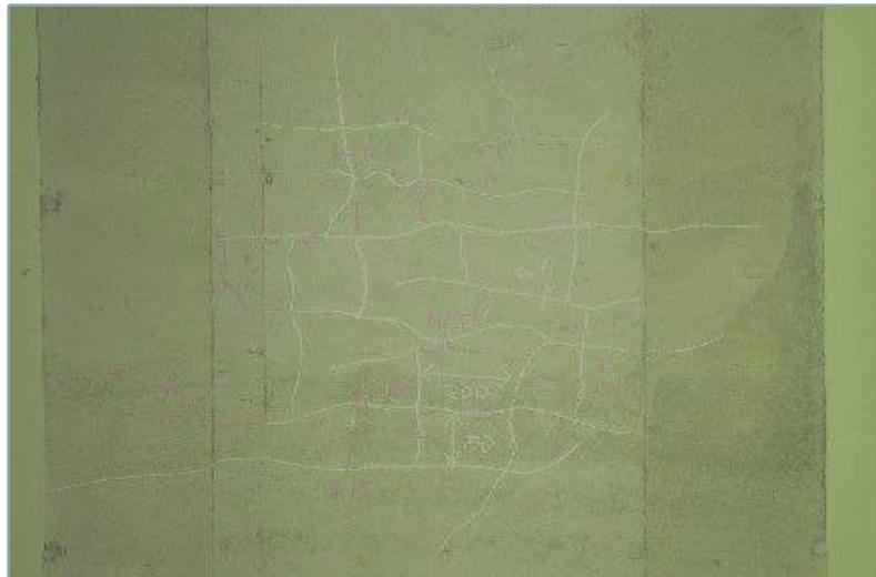
損傷状況(床版ひびわれ)
