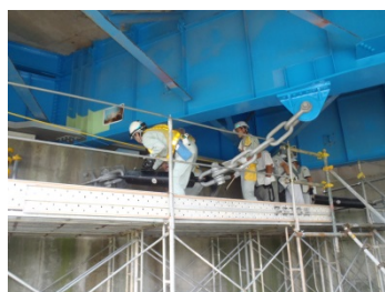
▲桁端部の腐食状況確認
