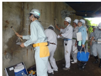
▲橋台(下部工)の打音診断状況
