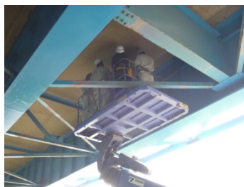
▲リフト車を用いた床版の点検
