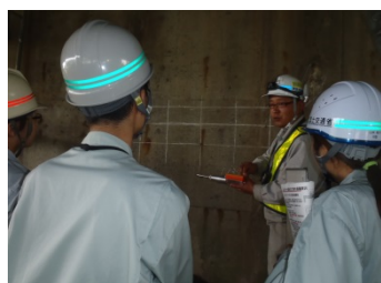
▲鉄筋探査による配筋確認
