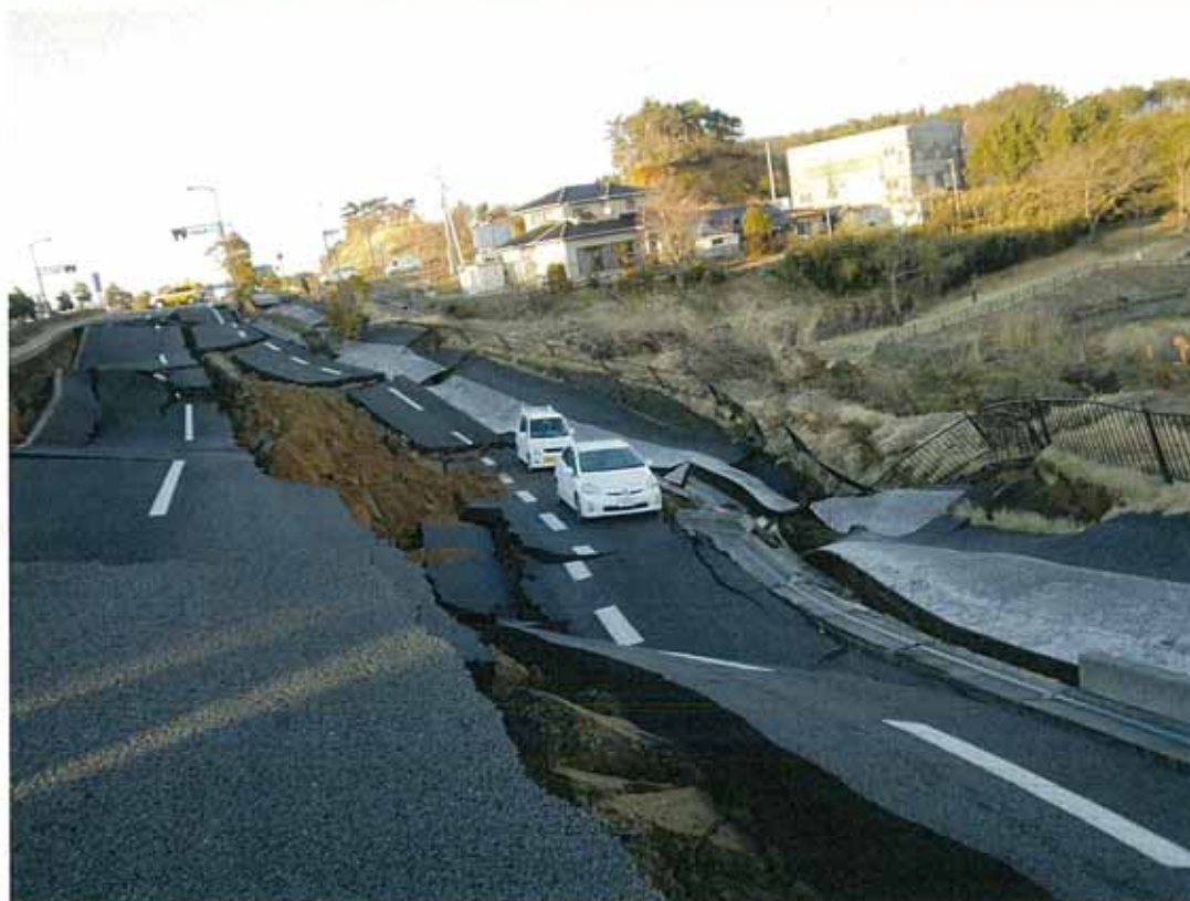
⑭国道6号 路面崩壊（福島県広野町）
