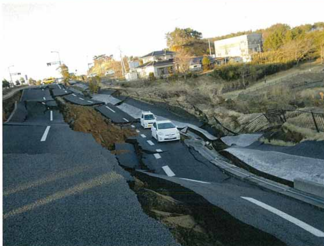
⑭国道6号 路面崩壊（福島県広野町）
