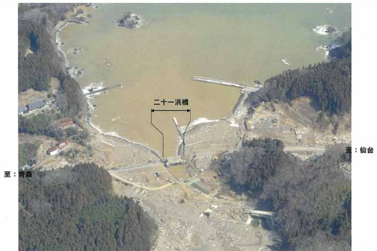
⑧国道45号 二十一浜 (ニジユウイチハマ) 橋 (宮城県気仙沼市) L=17m
