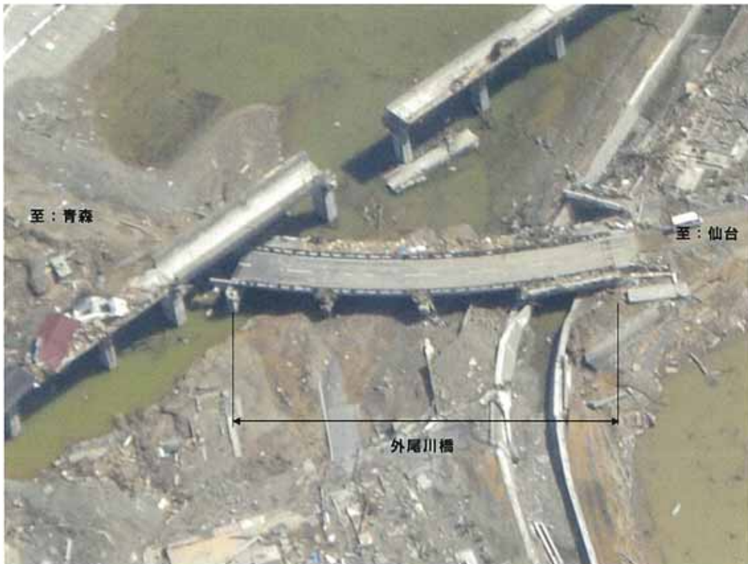
⑦国道45号 外尾 (ソデオ) 川橋 (宮城県気仙沼市) L=60m
