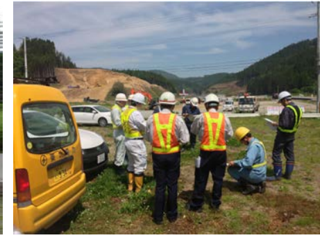
▲ 支障物件移設現場立会
