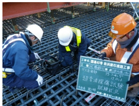
▲現地立会 （圧接超音波探傷試験）
