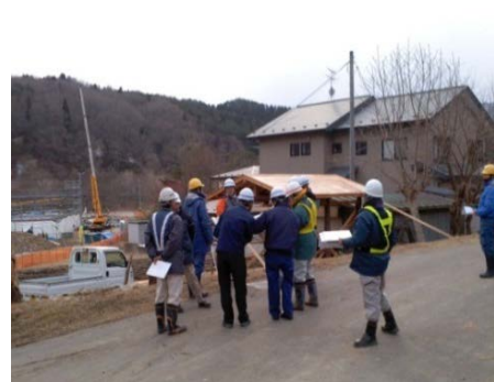
▲支障物件移設現場立会
