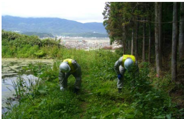
▲資機材搬入ルート調査(陸前高田工区)
