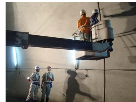
▲覆工コンクリート品質確認
