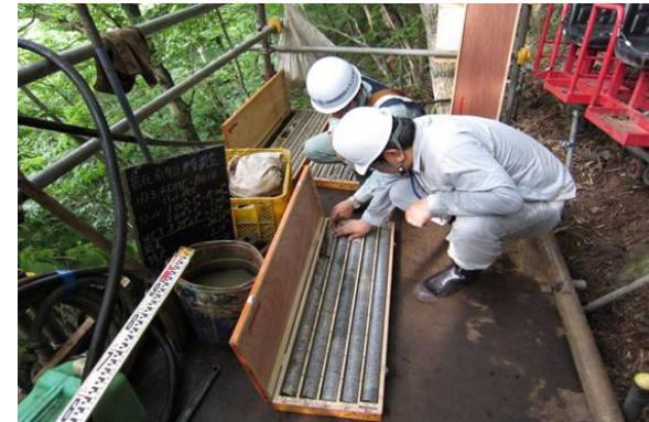
▲ ボーリングの確認
