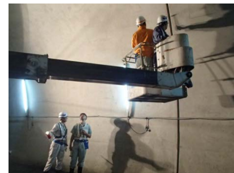
▲覆工コンクリート品質確認
