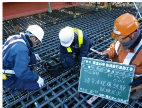
▲現地立会 （圧接超音波探傷試験）
