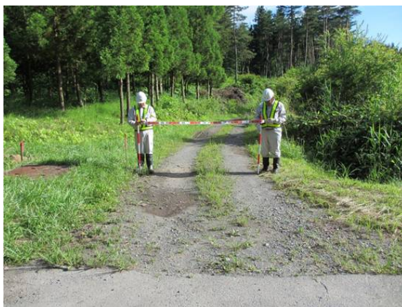
▲ 工事用道路調査
