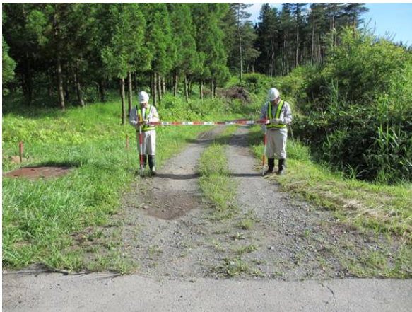
▲ 工事用道路調査
