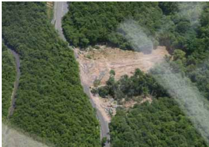
6 / 17 撮影 法面崩落
