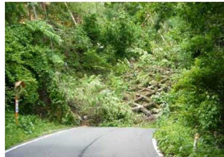
6 / 16 撮影 法面崩落
