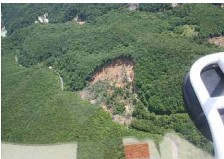
6 / 17 撮影 法面崩落
