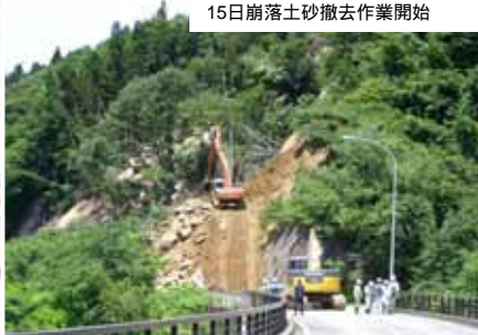
15日崩落土砂撤去作業開始
