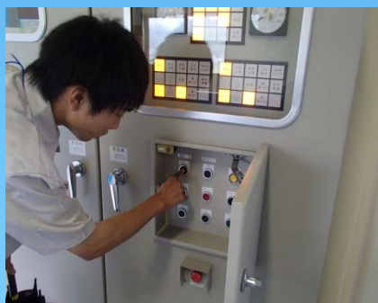
▲前山川水門にて管理施設操作
