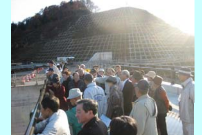
○治水見学会(森吉山ダム工事現場) 【主催】米代川治水期成同盟会 森吉山ダム建設促進期成同盟会
